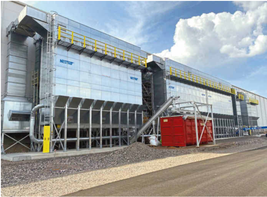
/ Die modular erweiterbaren Jet-Zwischenfilter mit Containerausladung sorgen in der Fertigung des Küchenmöbelherstellers Nobia für eine effiziente Absaugung von Holzstaub und -spänen.
