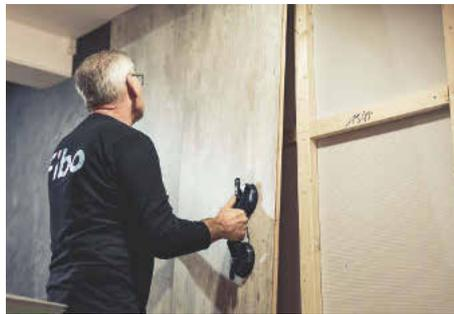
Die Wandpaneele „Fibo“ kann mit herkömmlichen Maschinen bearbeitet werden. Durch ein patentiertes Klicksystem wird das Produkt wasserdicht.
