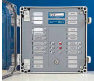
Brandschutz geht alle an: T&B Kompakt-Funkenlöschanlage
