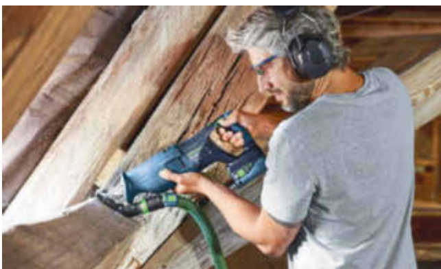
Ergonomie von innen heraus: Das Getriebe der neuen Akku-Säbelsäge von Festool reduziert die Vibration um 40 Prozent
