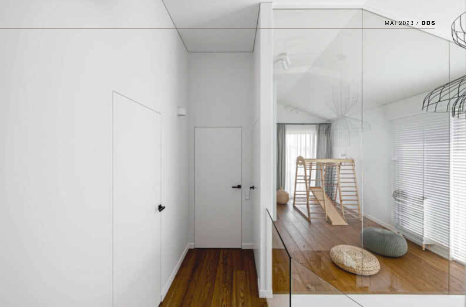
Ein Ganzglaselement ersetzt die Wand zwischen Treppenhaus und Spielzimmer. Ebenso wurde ein Teil der Wand zwischen den Kinderzimmern verglast. Die Helligkeit in den Räumen sorgt auch bei Regenwetter für heitere Raumstimmungen
