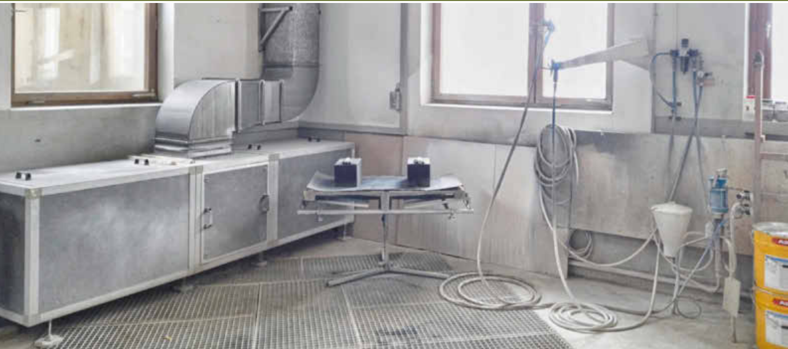
Größere Änderungen oder Umbauten im Lackierraum waren nicht notwendig
