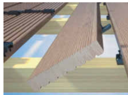
Die Diele umdrehen, in den Clipper der vorherigen schieben und verschrauben
