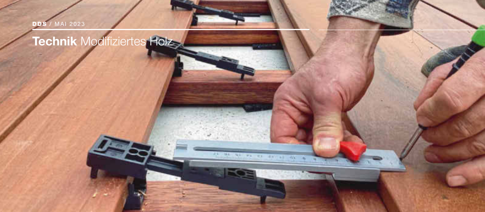
Anzeichnen der Montageposition der Clipper auf den Terrassendielen
