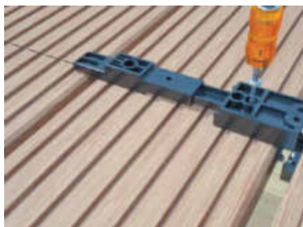
Der Clipper wird auf der Unterseite der Diele verschraubt
